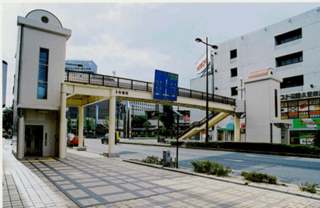
横断歩道橋の左右2基のエレベーターは、自動運転機能を有しています。（実例写真）
