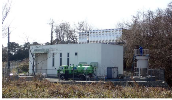
油木地区 近田浄水場
