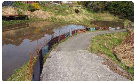
(侵入防止柵は欠かせない)
